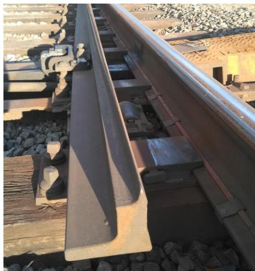
Abbildung 20 abliegende Zunge auf Gleitsattel
