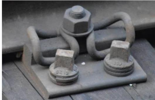
Abbildung 17 KS-Befestigung mit Spannklemme [62]
