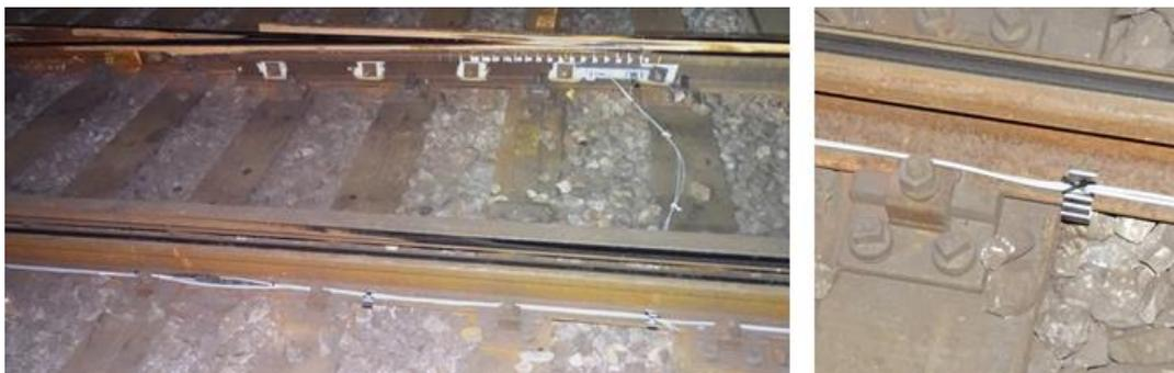
Abbildung 73 Befestigung der Kabel beim Herzstück (links) und Zunge (rechts)
