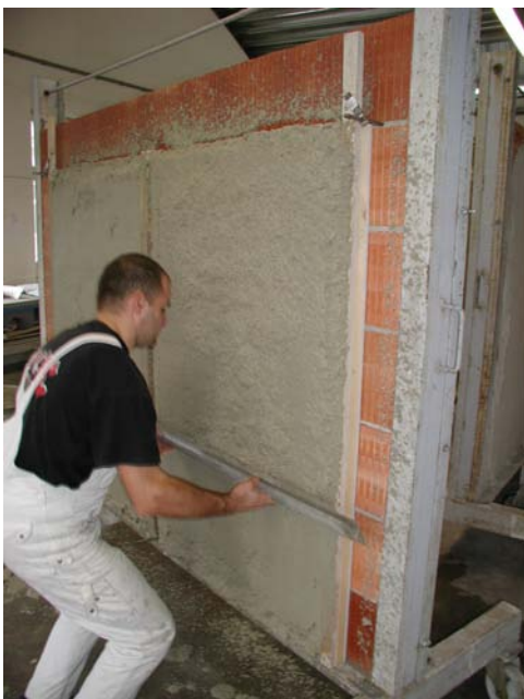
Abb. 20 Abziehen des Putzmörtels
