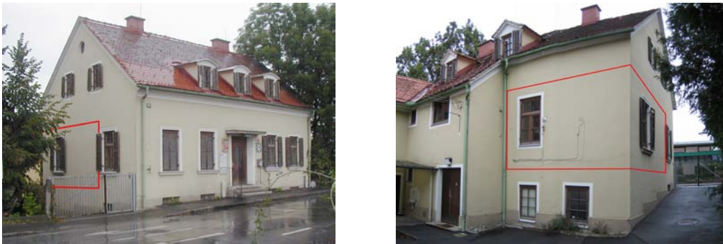
Abb. 25 Süd-Ost- und Hofansicht des Versuchshauses (mit skizzierten Versuchsräumen)
