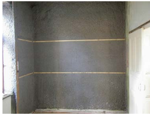
Abb. 28 Fertige Zellulose-Innendämmung mit Abzugsleisten
