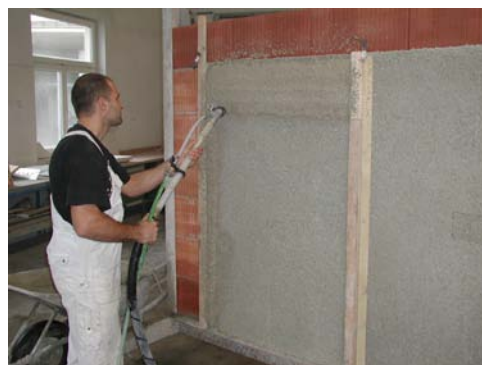
Abb. 19 Aufspritzen des Putzmörtels
