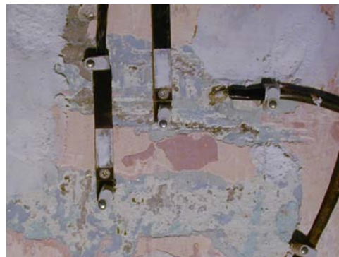
Abb. 32 Eingebaute Temperatur-/Feuchtefühler vor dem Aufspritzen der Zellulosedämmung
