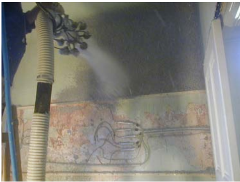
Abb. 27 Der neu entwickelte Spritzkopf im Einsatz an der Versuchswand
