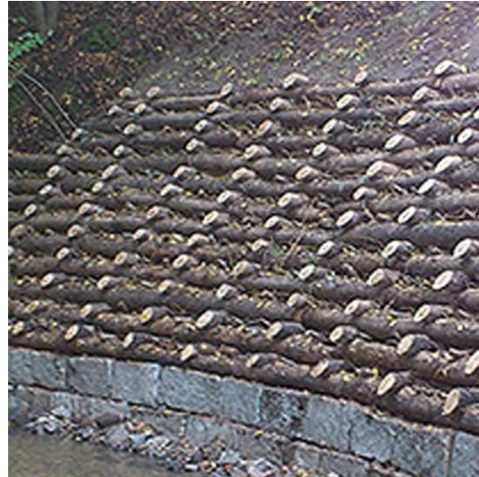
Abb. 10: Links – Raumgitterkonstruktion aus Betonfertigteilen (Bellingham); Rechts – Holzkrainerwand (Giehler)
