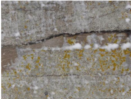
Abb. 43: Links – Betonausblühungen in der Nähe eines Risses; Rechts – Betonausblühungen an einer Spritzbetonsicherung in der Nähe einer Straße mit Tausalzverwendung
