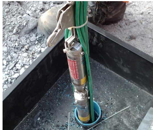
Abb. 106: Inklinometer in einem Bohrloch (Stump)
