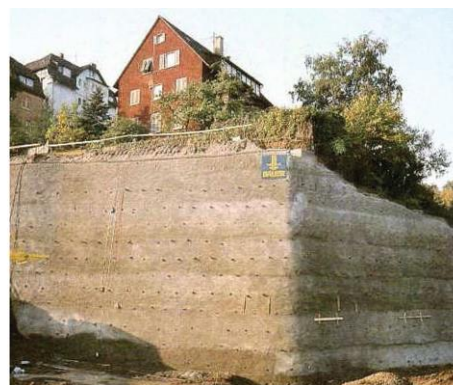
Abb. 29: Links – Anschluss einer Galerie an ein Stützbauwerk; Rechts – Gebäude hinter einem Stützbauwerk (Kolymbas, 2011)
