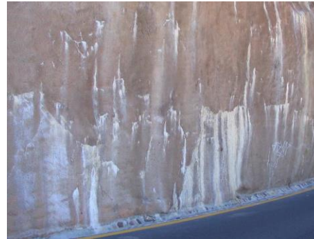
Abb. 43: Links – Betonausblühungen in der Nähe eines Risses; Rechts – Betonausblühungen an einer Spritzbetonsicherung in der Nähe einer Straße mit Tausalzverwendung
