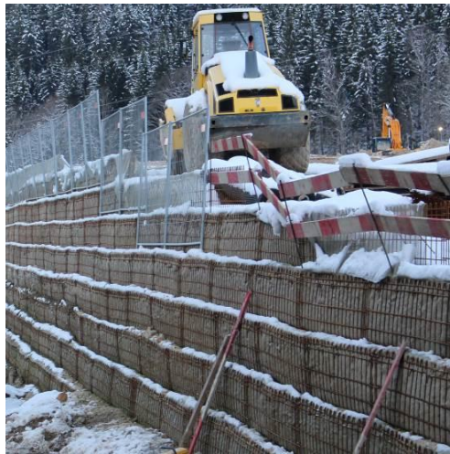
Abb. 13: Links – lagenweise Herstellung eines Bewehrte Erde Körpers; Rechts – Ansicht eines fertiggestellten Bewehrte Erde Körpers
