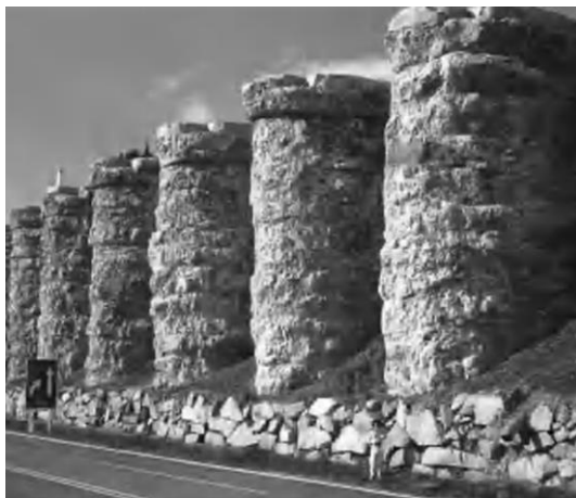
Abb. 16: Links – Ansicht einer fertiggestellten Brunnenwand zur Sicherung eines Rutschhanges; Rechts – Brunnenwand im verwachsenen Zustand (Brandl, Konstruktive Hangsicherung, 1986)
