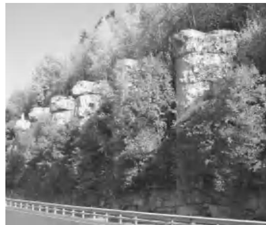
Abb. 16: Links – Ansicht einer fertiggestellten Brunnenwand zur Sicherung eines Rutschhanges; Rechts – Brunnenwand im verwachsenen Zustand (Brandl, Konstruktive Hangsicherung, 1986)
