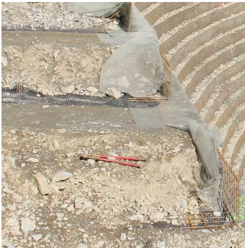
Abb. 13: Links – lagenweise Herstellung eines Bewehrte Erde Körpers; Rechts – Ansicht eines fertiggestellten Bewehrte Erde Körpers
