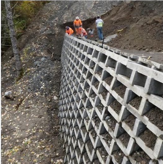
Abb. 10: Links – Raumgitterkonstruktion aus Betonfertigteilen (Bellingham); Rechts – Holzkrainerwand (Giehler)
