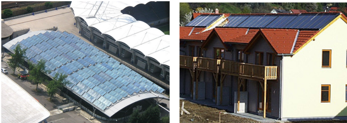
Abbildung 2.1: Solaranlagen Stadion Liebenau (links) und Judendorf (rechts)
