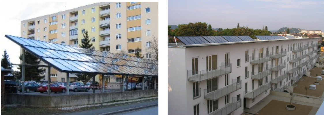
Abbildung 2.2: Solaranlagen Grottenhofstraße (links) und Eggenberger Allee (rechts)
