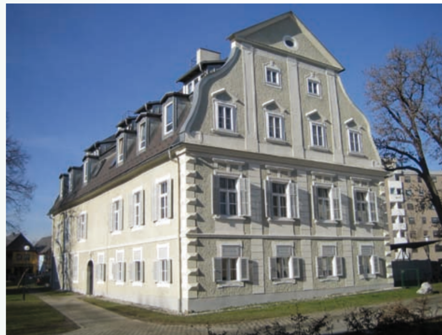
Abb. 5 Südostansicht des Gebäudes mit Versuchsräumlichkeiten im Erdgeschoss
