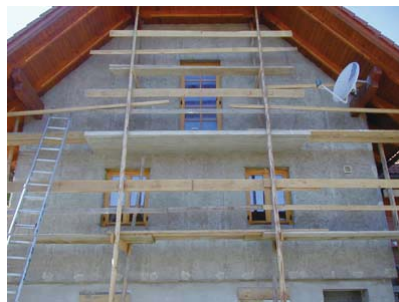
Prototyp des Zellulose-Wärmedämmverbundsystems vor dem Verputzen, Grabenwarth/Ligt
