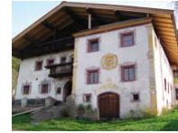
Bauernhaus, Bauzeit: ca. 14. Jh., Mischbauweise, Außenwanddicke ca. 60 cm. Zwei Sanierungsvarianten standen zur Auswahl: Zellulose-Innen-dämm-system oder als Alternative eine Wandheizung an Außenwänden. Aufgrund der niedrigen Betriebskosten entschied sich das Bauherrn-Team für die Sanierung mit Zellulose. Auch die Energie Tirol sowie das Bundesamt unterstützen das Vorhaben.
