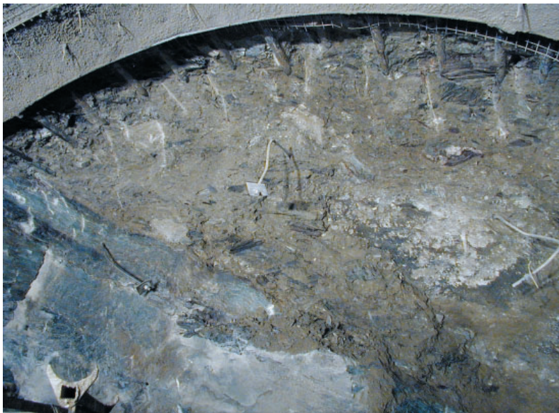
Bild 5 Grenze Lok- kergestein/Grund- gebirge (Quarzphyllit) bei Tunnelmeter 191 bis 192; Detail von Bild 4.
