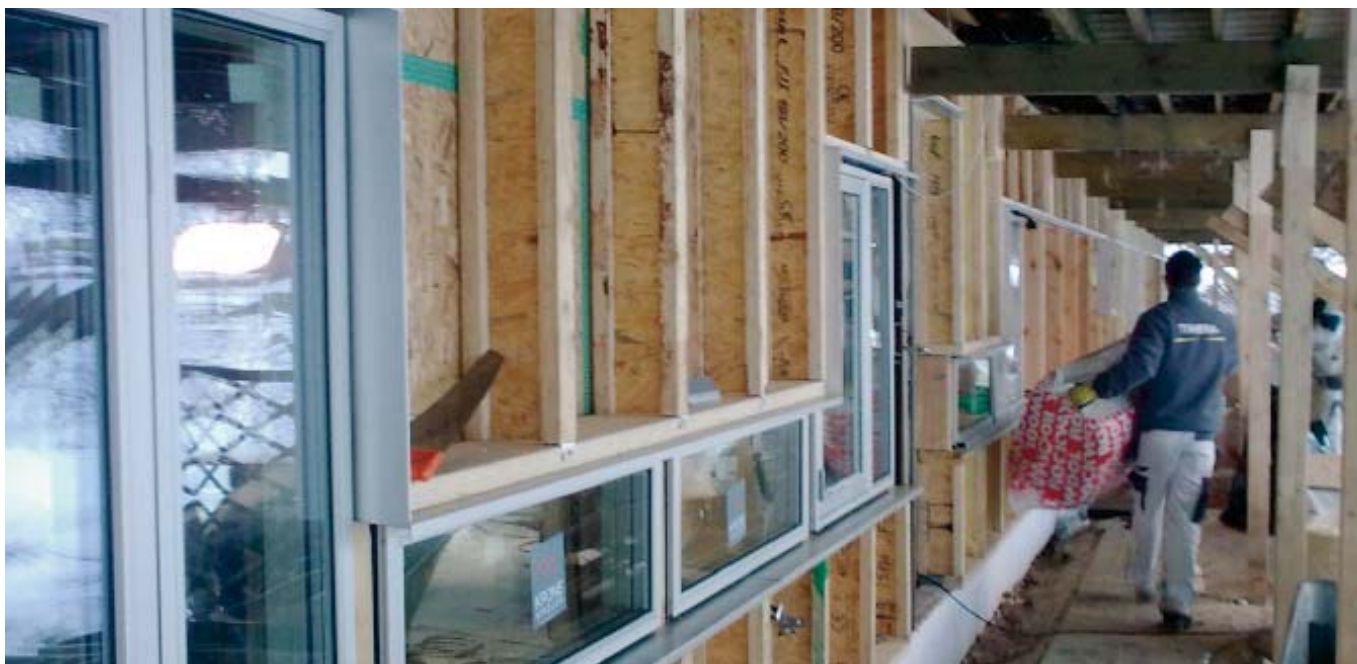
Kindergarten in Høje-Taastrup, Denmark. Photo: Høje-Taastrup municipality
