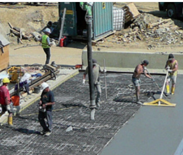
Datenerhebung auf der Baustelle (Betonierarbeiten mit Herzfrequenzaufzeichnung)
