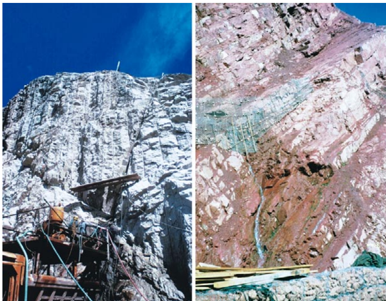
Bild 2 Beispiele von potenziellen Versagensmechanismen in Zusammenhang mit Störungen oder Harnissen in verschiedenen Maßstäben.
