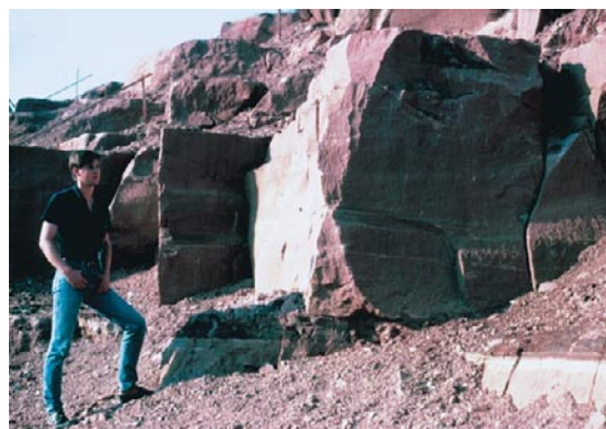
Fig. 10 Close up of one claystone layer and fracturing of the overlying sandstone. Bild 10 Detailansicht einer Tonsteinlage mit darüber liegendem Sandsteinblock.
