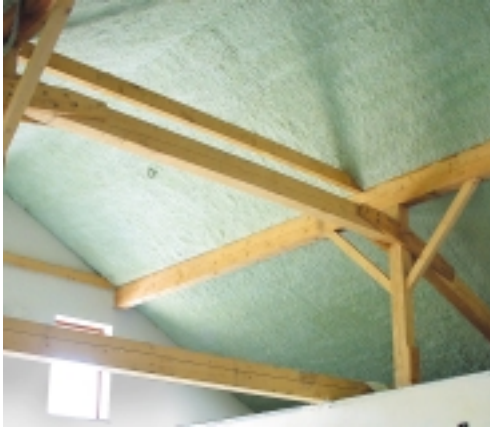
Abb. 71 Aufgespritzte Akustikbeschichtung
