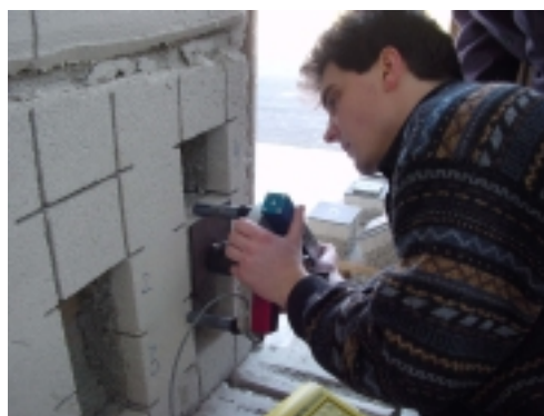
Abb. 68 Ansetzen des Prüfgerätes
