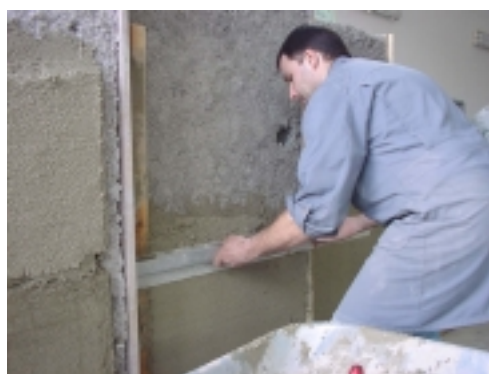
Abb. 63 Abziehen der Putzschichte - ThermoExtra
