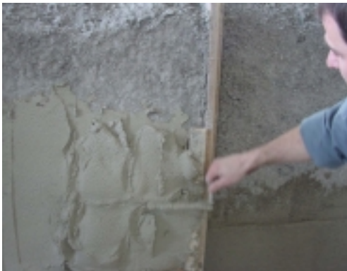
Abb. 65 Anwurf FaserLeichtPutz
