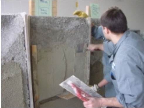
Abb. 64 "Vorstreichen" einer dünnen Putzschicht
