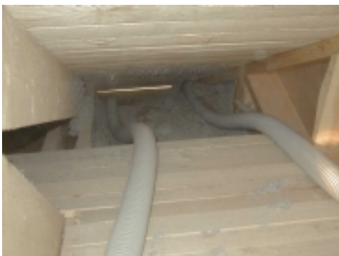
Abb. 13 Einblasen einer Dachschräge vom Spitzboden aus
