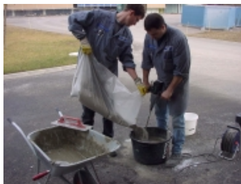
Abb. 61 Anrühren des Putzes
