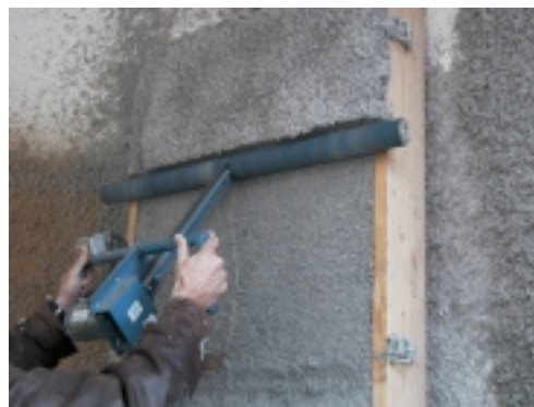
Abb. 14 Abziehen der aufgespritzten Dämmschicht
