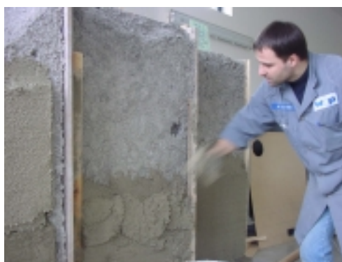
Abb. 62 Anwurf von ThermoExtra
