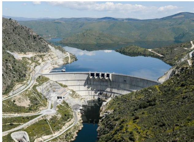
Fig. 1 Overall view of the Baixo Sabor dam
