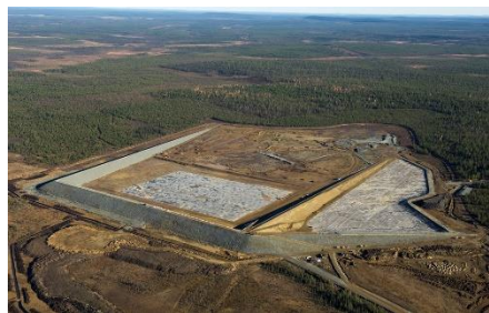
Fig. 10. Kiitilä site: general view
