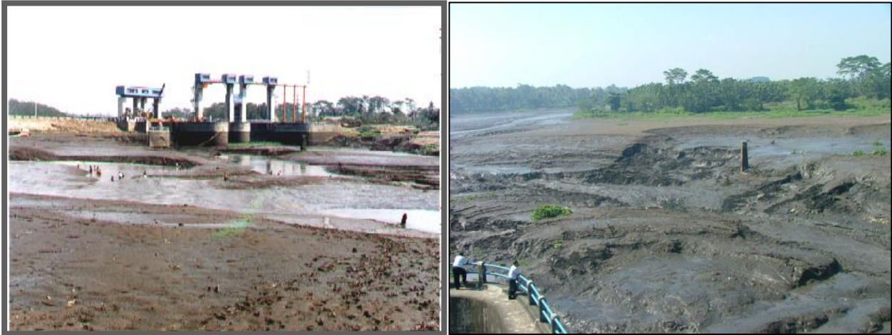
Figure 4. The condition of Sengguruh reservoir sedimentation L'état de la sédimentation du réservoir de Sengguruh
