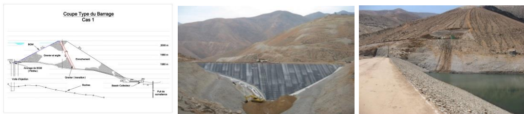
Fig. 5. Cerro Lindo dam:
