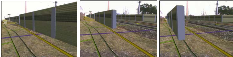
Abb. 10: Geplante Lärmschutzwand entlang einer Eisenbahntrasse. Die geplante Lärmschutzwand ist Gegenstand der Vor-Ort Besichtigung mit den VIDENTE System, um Überschneidungen mit bestehender Leitungsinfrastruktur festzustellen (Daten von ÖBB-Infrastruktur Bau AG).
