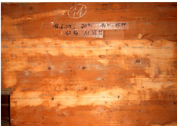
Abb. 3.5: abgelenkter Querträger mit schmalen verpressten Rissen (Foto: Finnforest Merk)
