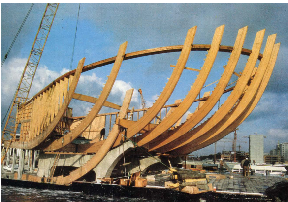
Abb. 2.3: Montage der Haupttragelemente des Hörsaales 1 aus [2]
