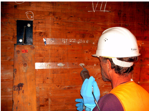
Abb. 3.3: Verpressen der abgeklebten Risse (Foto: Finnforest Merk)
