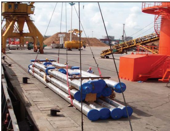
Abb.10 a: Anlieferung der 20 m Rohre einer GIL
