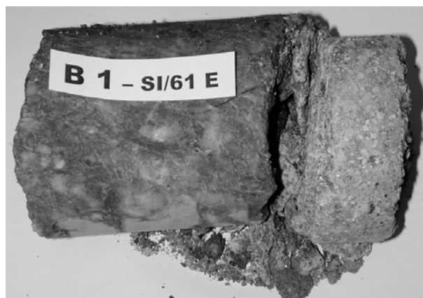
Abbildung 2. Bohrkern B1 SI/61 – Zersatzzone zwischen Mauerwerk (links) und Spritzbeton
