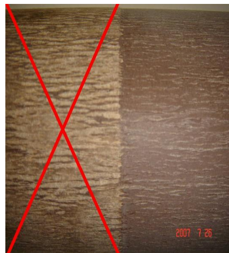
Bild 16 Durch Wasser geschädigte Harzoberfläche
