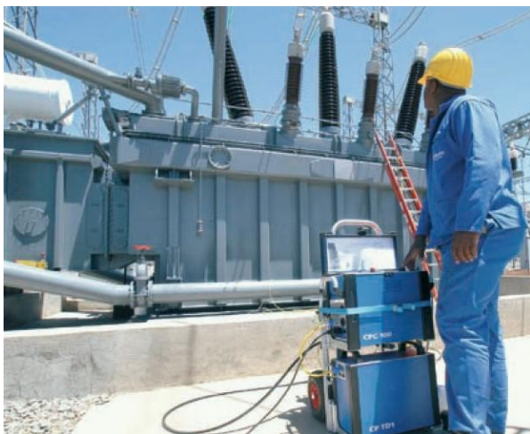
Bild 2 Vor-Ort-Messung der dielektrischen Antwort von Hochspannungsdurchführungen
