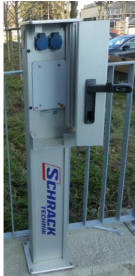
Abbildung 3: Stromtankstelle der Fa. Schrack, Inffeldgasse 18 in Graz
