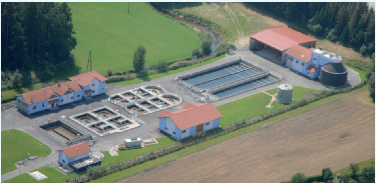
Figure 2: WWTP Freistadt, Upper Austria (RHV Freistadt und Umgebung)
