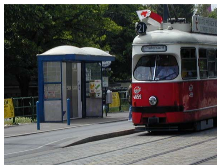
Abb. 1: Typisches Beispiel einer befahrbaren Haltestellenanhebung
