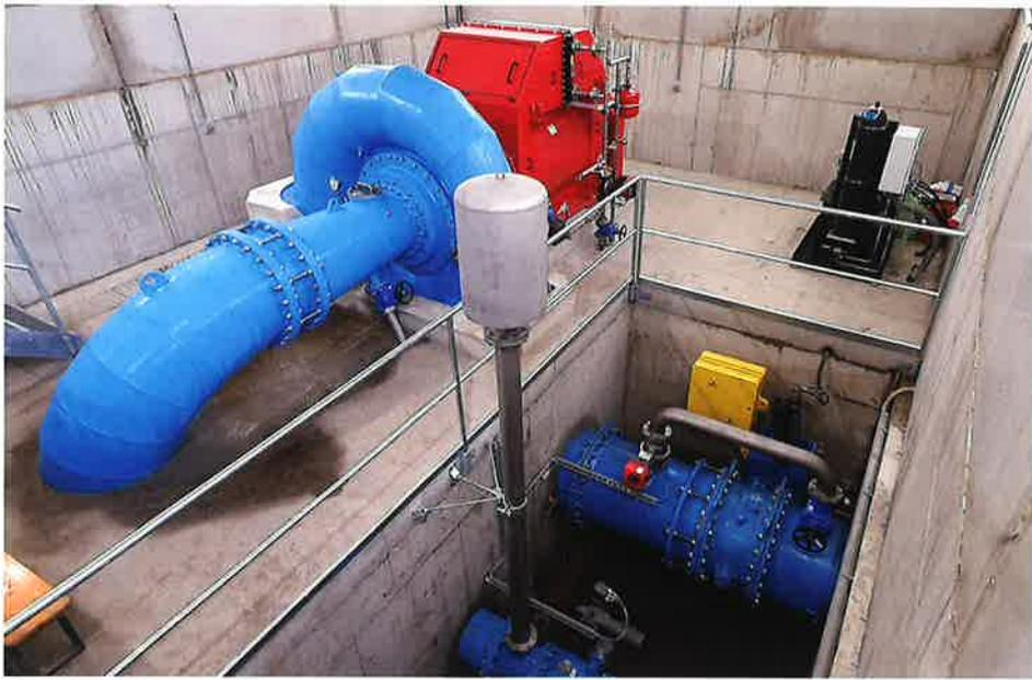
Abb. 10: Fotografische Abbildung der neuen Diagonalturbine im Krafthaus
