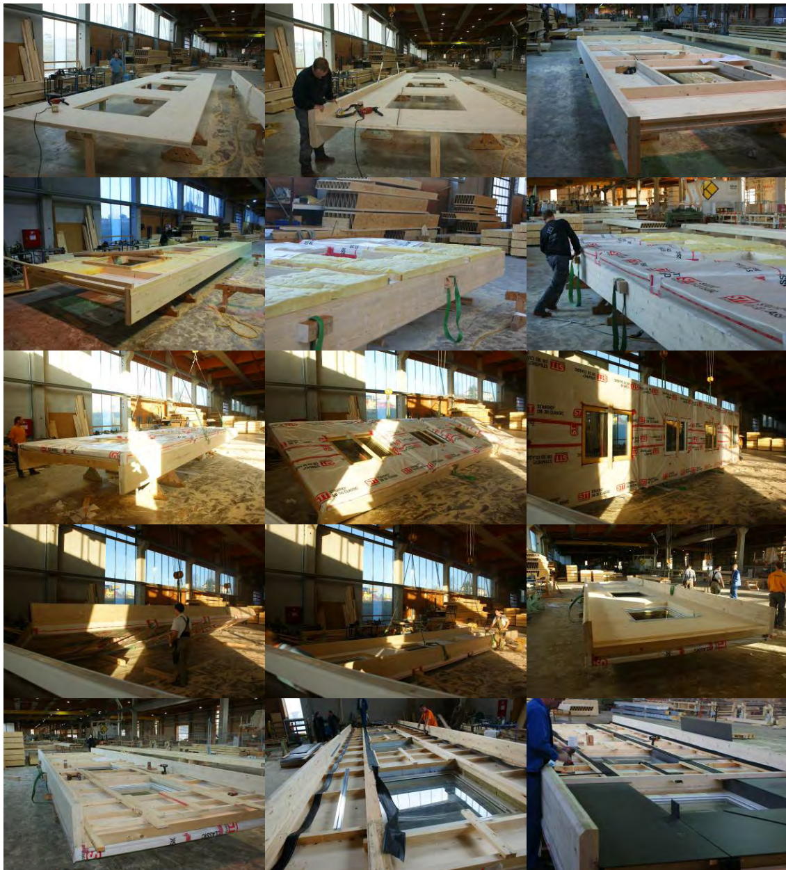
Abbildung 41: Ausschnitte der Fertigung des Prototyps 1 (Massivholzplatte) eines vorgefertigten Fassadenelementes (Quelle: AEE INTEC)
