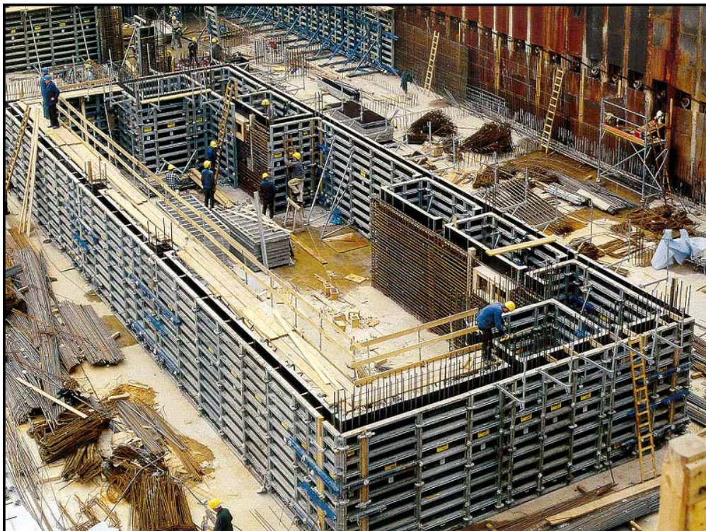
Abb. 1-3 Doppelhäutig geschalte Wände - Beispiel mit einer Rahmenschalung [Quelle: Doka]
