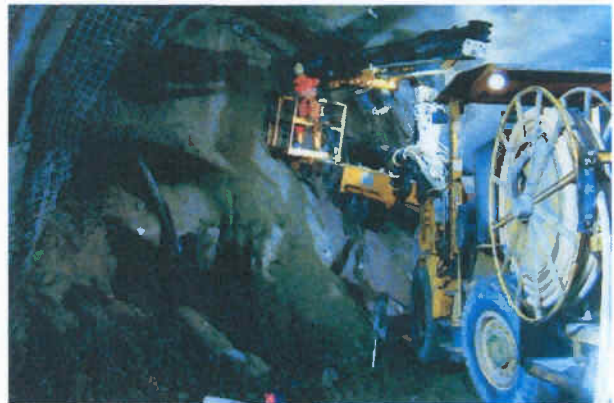
Seit April 1999 errichtet die BEG vier Erkundungsstollen im Tiroler Unterinntal.
