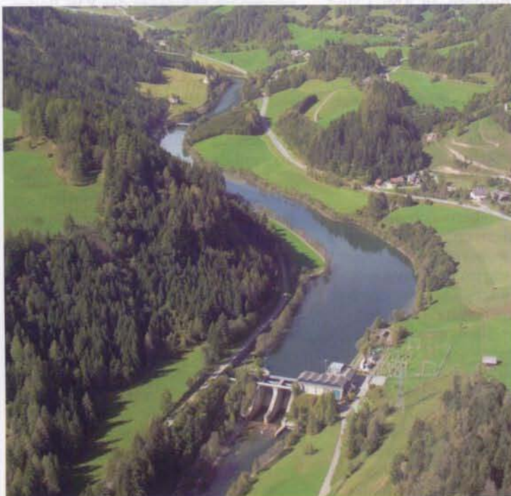
Abb. 2. KW Bodendorf, Ansicht der Wehranlage und des Krafthauses vom Unterwasser
