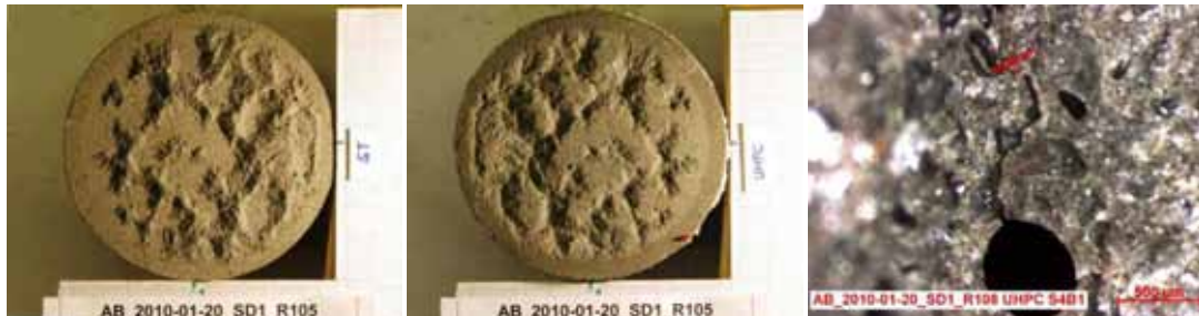
Abbildung 5.13: Bruchfugen des a) Probekörperunterteils, b) Probekörperoberteils, c) Lichtmikroskopische Aufnahme einer Vertiefung im Beton des linken Bildes mit 50 µm breitem Riss, der in einer großen Luftpore mündet, Bildbreite 2,5 mm
